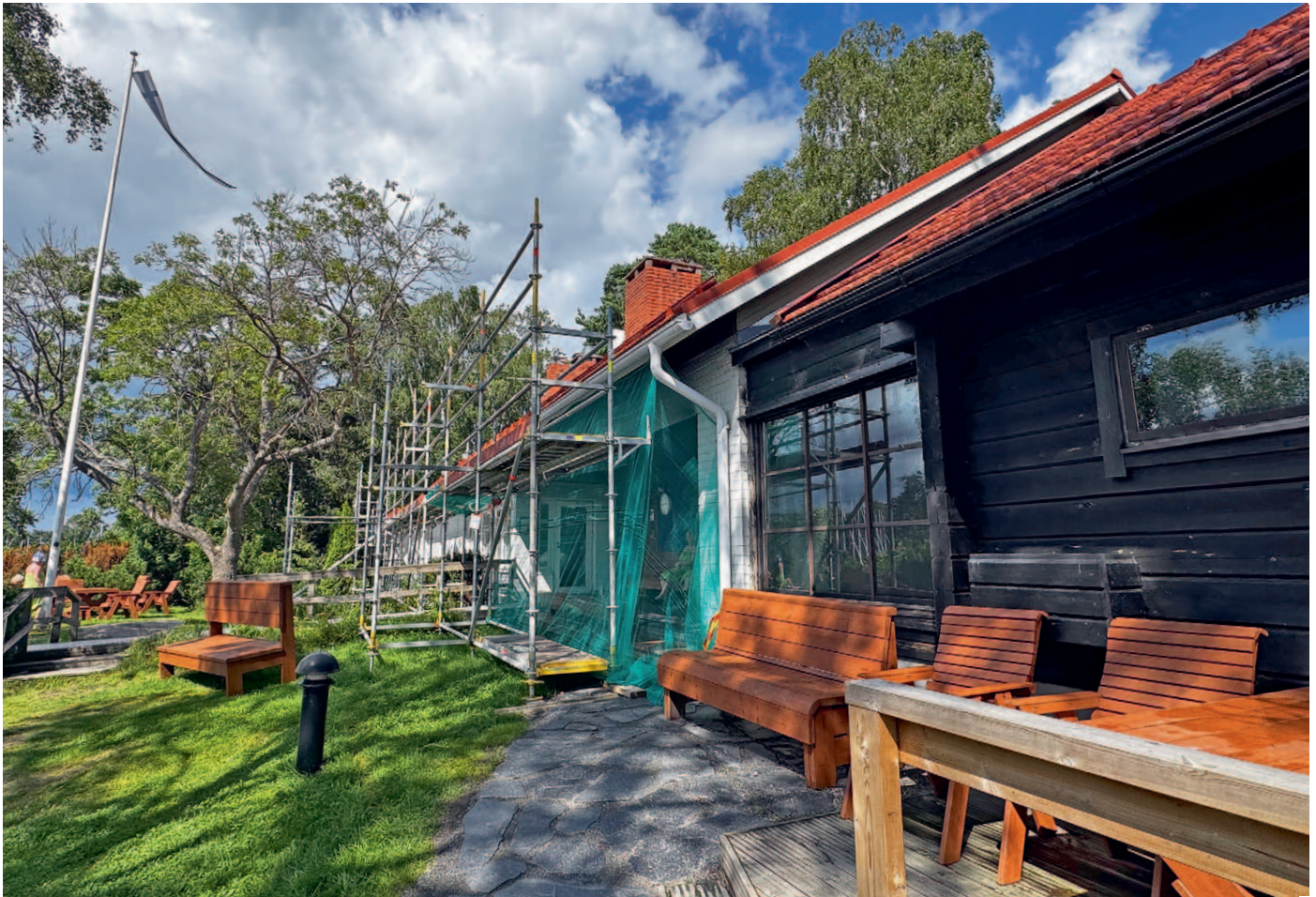
Tukevat rakennustelineet ovat olennainen osa turvallista työmaata.
