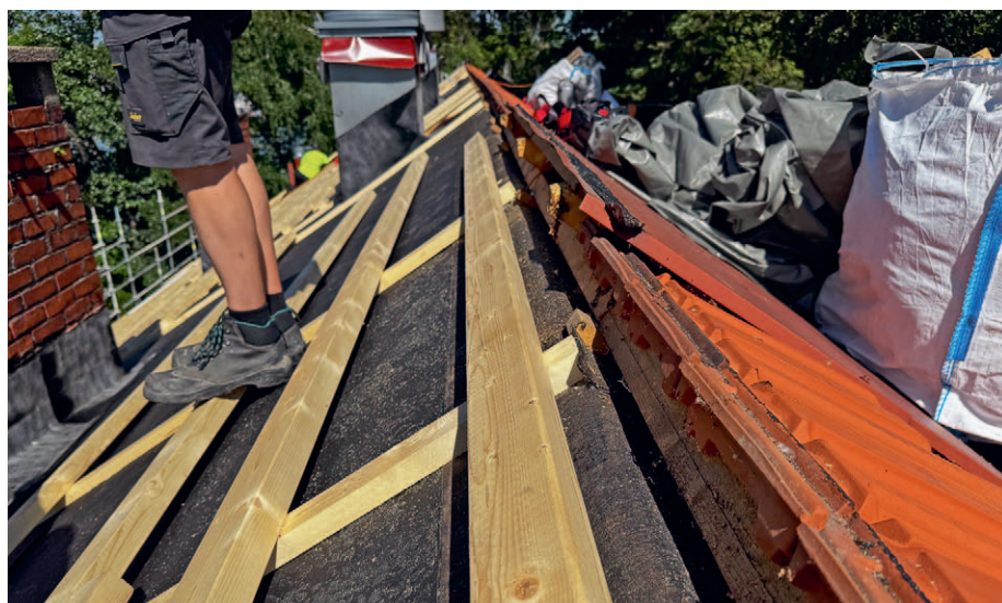
Reilun neljän viikon aikana urakassa uusittiin niin kermialuskatteet, tuuletusrimat, ruoteet kuin savitiilikatteetkin.
