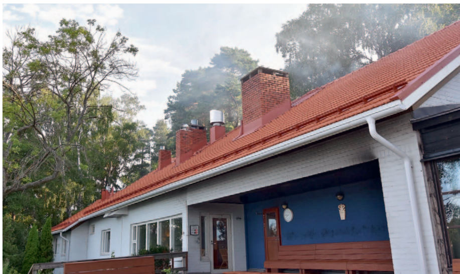
Saunatalo valmistui vuonna 1952 Helsingin olympialaisiin. Säännölliset ja suunnitelmalliset huolto- ja korjaustoimet ovat pitäneet rakennuksen hyvässä kunnossa.
