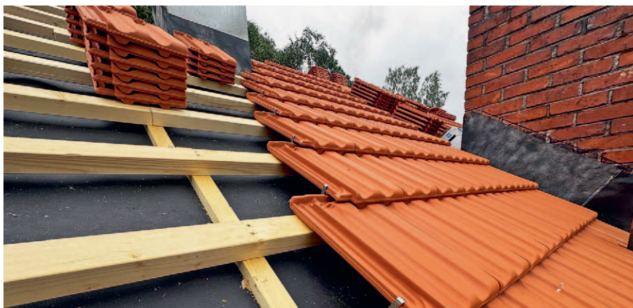
Uusien savikattotiilien profiili muistuttaa katon alkuperäisten käsin puristettujen savikattotiilien profiilia, joten katon ilme säilyi ennallaan.
