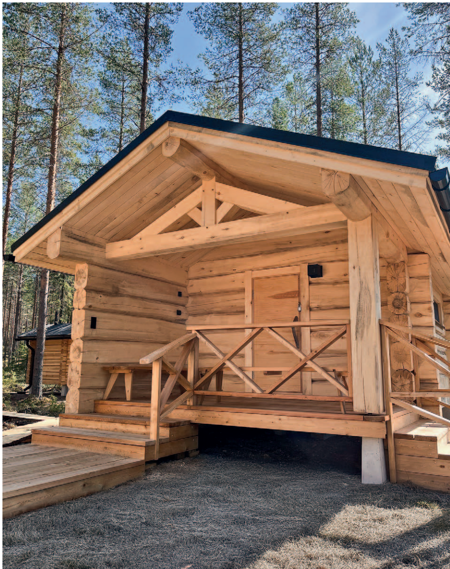
Käsityönä rakennetun saunan rosoista tunnelmaa ei voi korvata teollisesti tuotetulla puulla.
