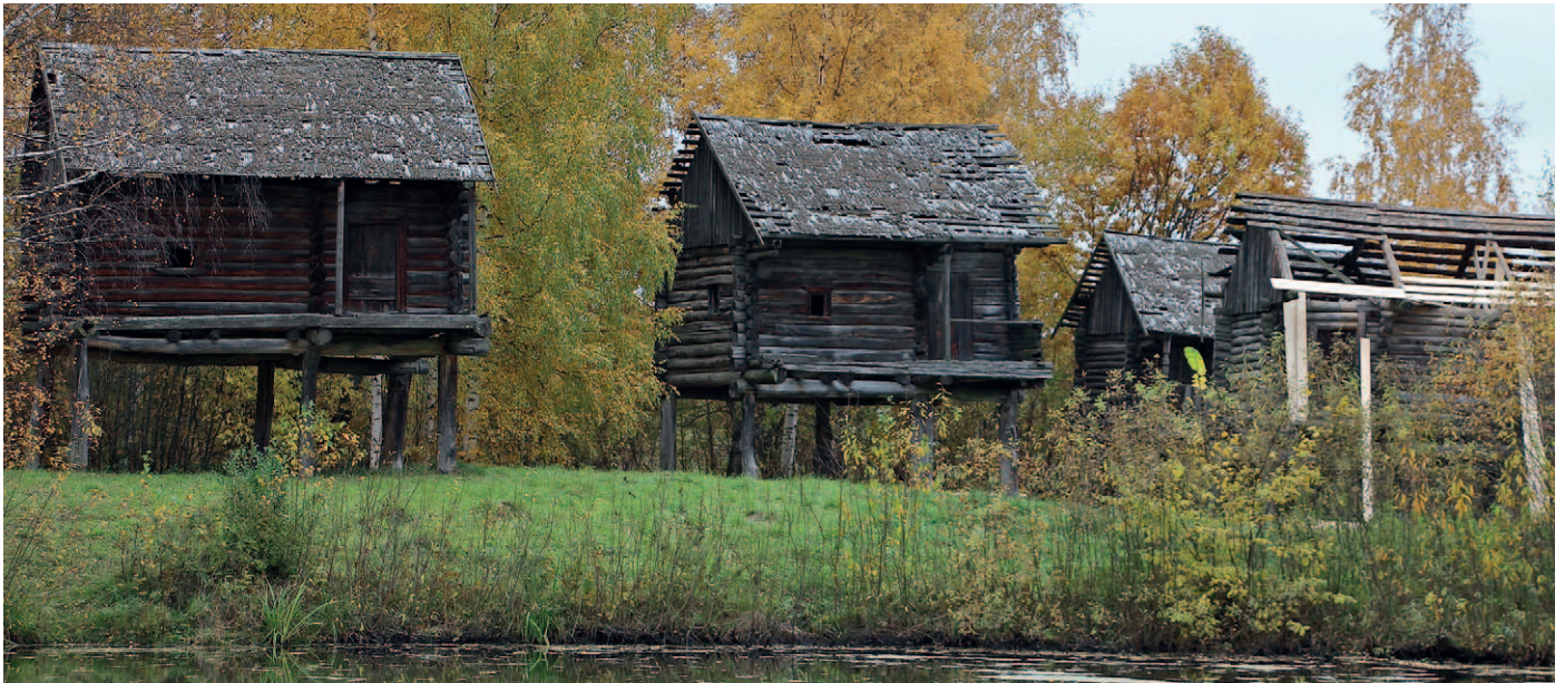
Tammipaalujuen varaan rakennetut 1800-luvun jalkasaunat Kostroman ulkomuseossa. Jalkasaunojen malkakattoja ovat haastattelemani informantit usein nimittäneet "čuhnalaisiksi": katto on tehty po-čuhónski tai pod čuhnú eli "suomalaisittain". Kostroma, 2018.
