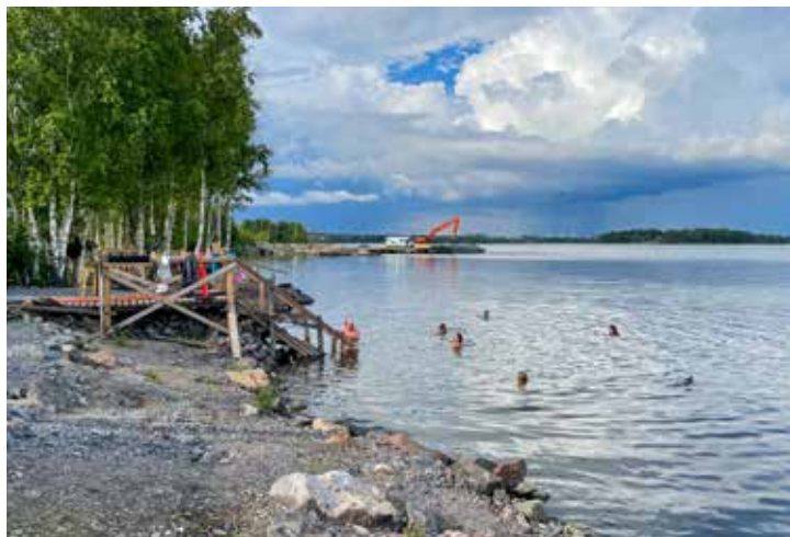
Uudelle Sompasaunalle rakennettiin talkoovoimin komea laituri, joka on kovassa käytössä saunojien toimesta.
