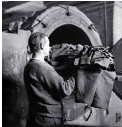
Venäläisten tekemä suuri täisauna oli suomalaisten käytössä Syvärillä 1942. Puhdistettavat vaatteet laitettiin uuneihin, joita oli kaikkiaan kuusi.
