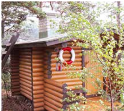
Saunan seuraavassa versiossa kiuas vaihtui kertalämmitteiseen ja kevythormi muurattuun hormiin.
