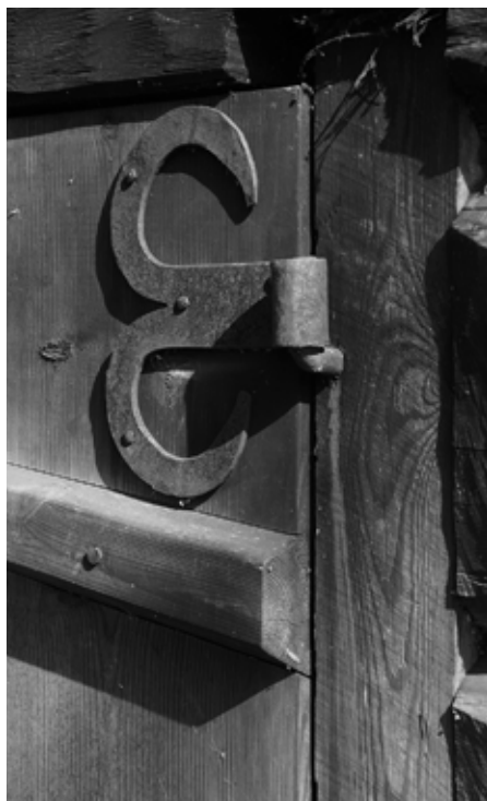
Virpiön saunan sarana saa taas käyttöä, kunhan rakennus saadaan saunottavaan kuntoon.
