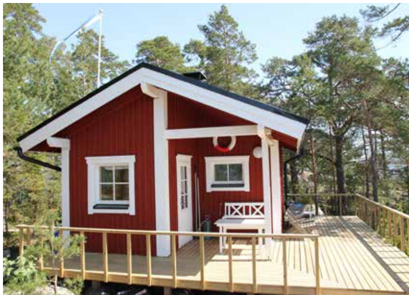
Mukavuudenhalu laittoj rakentamaan uuden saunan – ehkä loppuelämäksi.
