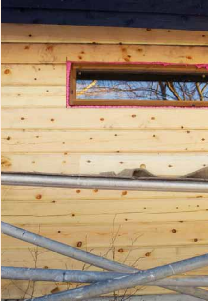
Nelosen seinärakenne palautettiin täyshirrestä tehdyksi.
