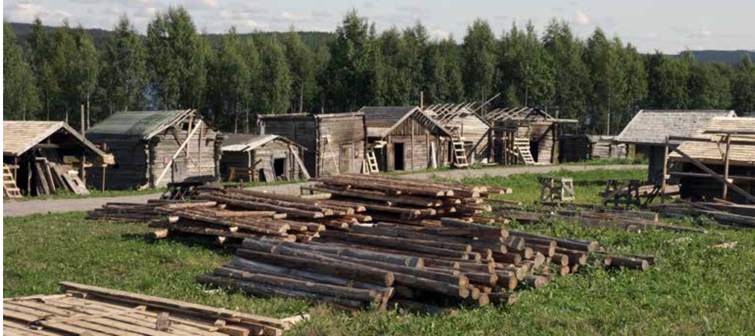
Sateisesta kesästä huolimatta työt etenivät Jämsän Saunakylässä – näkymä syyskuulta.
