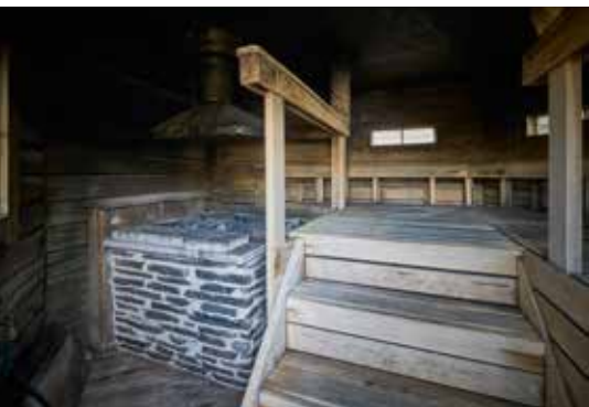
Saunasaaren kaikissa kolmessa saunassa on savusaunan kiuas. Niiden rakentamiseen Rainer Hanhilahti sai neuvoja mm. Suomen Saunaseuran Matti Kiviseltä ja Pekka Tommilalta.
