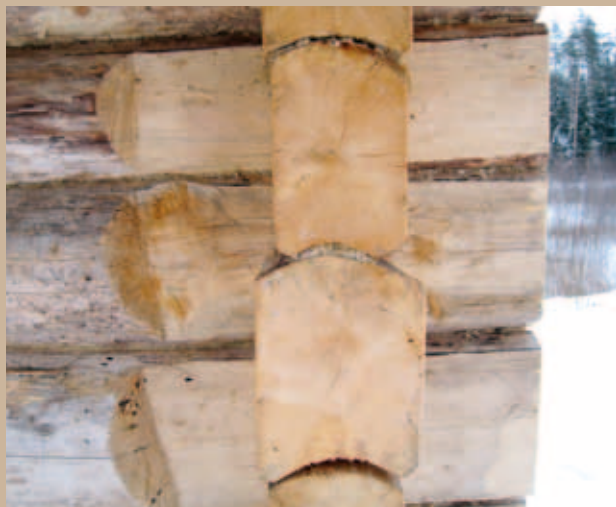
Saunan nurkkasalvoksen rakenne on pyöreään hirteen sovellettu suoranurkka.
