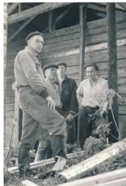
Kanasaaren saunanrakentajia kesäkuussa vuonna 1958. Alimmassa kuvassa etualalla Erkki Tanttua, joka osallistui itsekin rakennustöihin.
