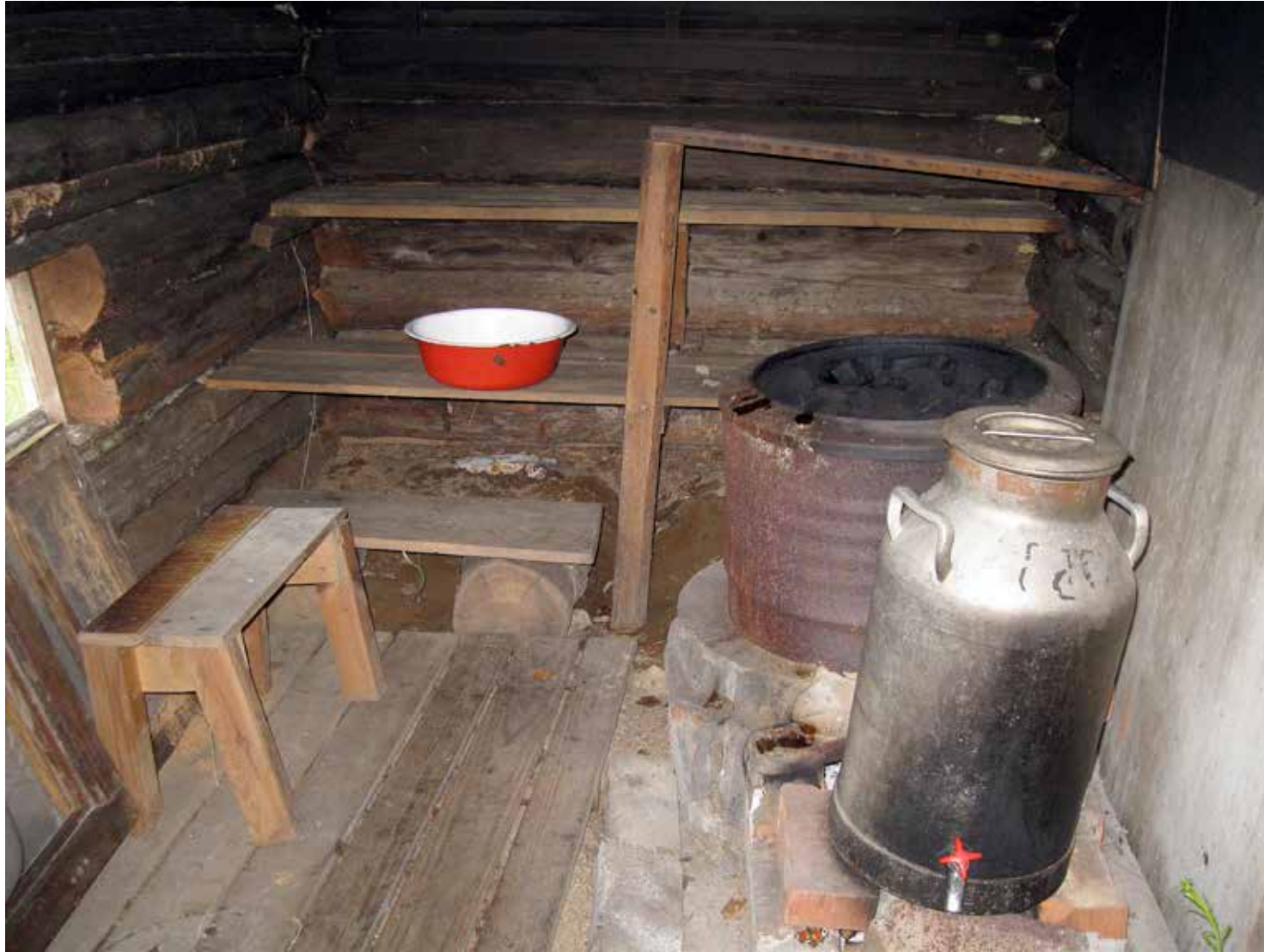
Kiuas on tehty tynnyrin puolikkaasta ja vesi lämpää erillisen tulisijan päällä maitotongassa, joka on varustettu hanalla.
