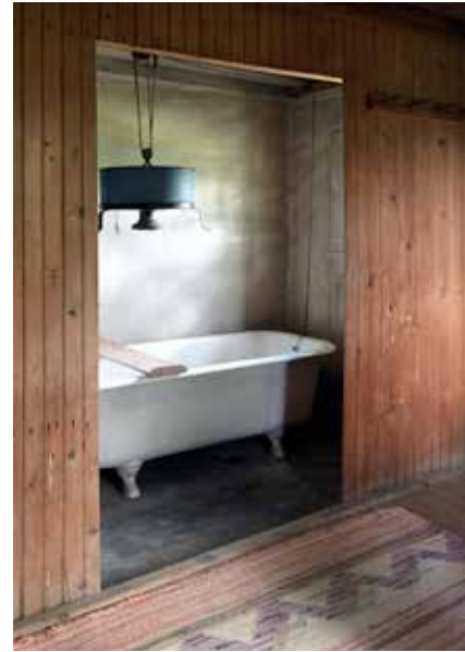
Saunan lauteet ovat yhtä selkeälinjaiset kuin itse rakennuskin. Amme oli Sibeliuksen mielipaikka. Sen yläpuolella riippuu Sauna-ILO -merkinen suihkuämpäri, jonka pohjassa olevasta kahvasta vetämällä kylpijä saattoi ottaa suihkun. Punatiilestä muurattuun savupiippuun liittyy kolme tulisijaa: saunan peltikuorinen kiuas, pesuhuoneen pata sekä pukuhuoneen pönttöuuni.
