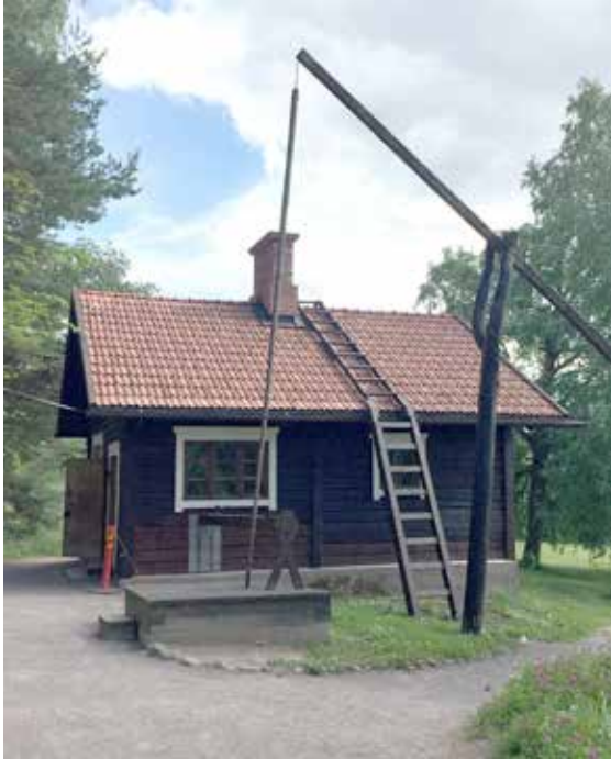
Veistoksellinen vinttikaivo vesikouruineen oli Aino Sibeliuksen kehittämä ratkaisu, joka paransi saunan toiminnallisuutta.
