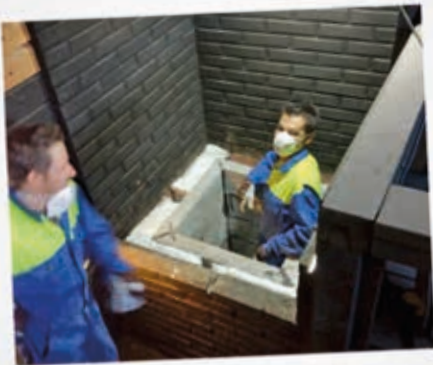
Viitosen ja Kolmosen Kiukaat uusittiin viime kesänä, tässä kuvaa viitosen Kiukaan Koosta ja rakenteesta sekä Refrakin ammattimiehistä jotka Kiukaat paikalla rakensivat.
