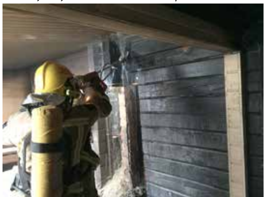
Sammuksessa käytettiin valtavan sam- mutustehon "Kopraa". Laite ruiskuttaa vettä yli 300 baarin paineella. Etuna on se, ettei rakenteita tarvitse purkaa enempää kuin on tarve.
