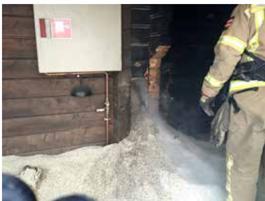
Saunojen välisessä tilassa oli eristemassaa, joka jouduttiin raivaamaan pois.
